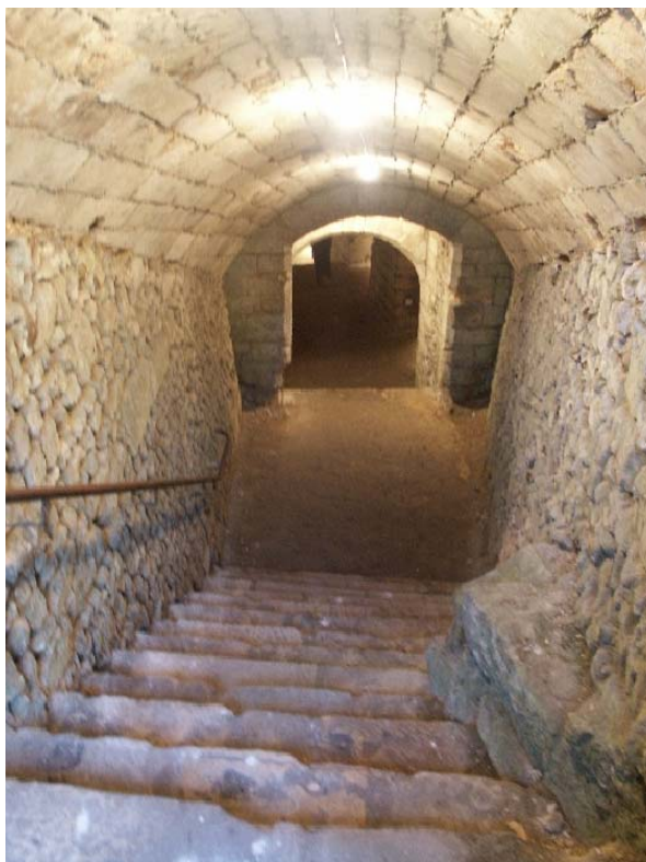
Partie aménagée pour les visiteurs des souterrains du château de Gisors Copyright photo Holy Land production
