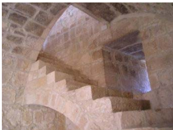
Château de Kolossi, ancienne commanderie des Templiers, puis des Chevaliers de l'Hôpital
